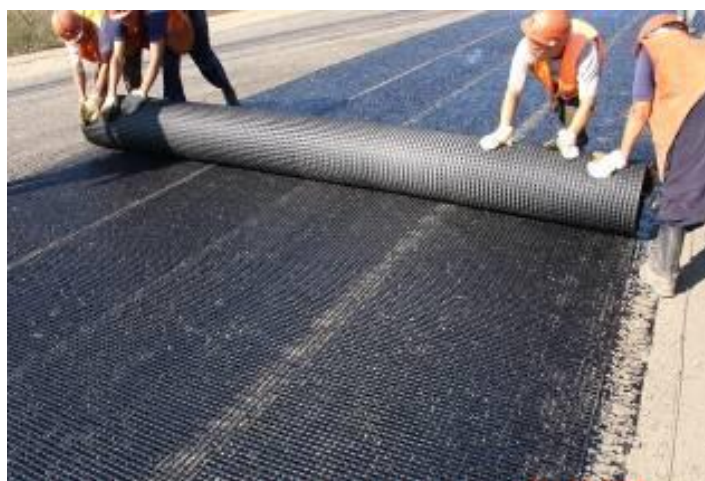
Рисунок 3 – Укладка геосетки вручную
