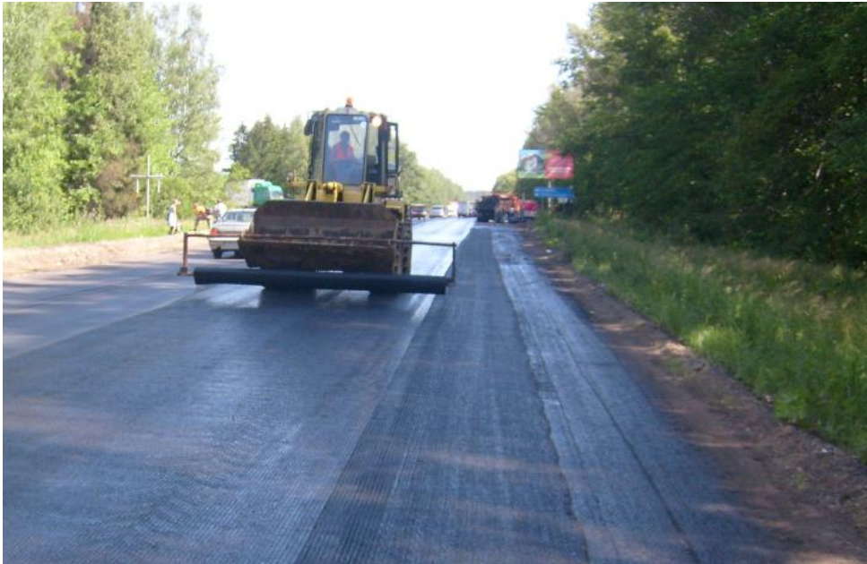
Рисунок 2 – Пример укладки геосетки на основание
